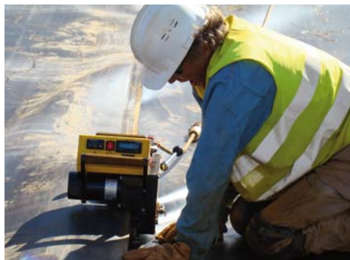
Il existe communément deux types de soudures pour ces géomembranes : l'extrusion au polyéthylène et la soudure par fusion.
