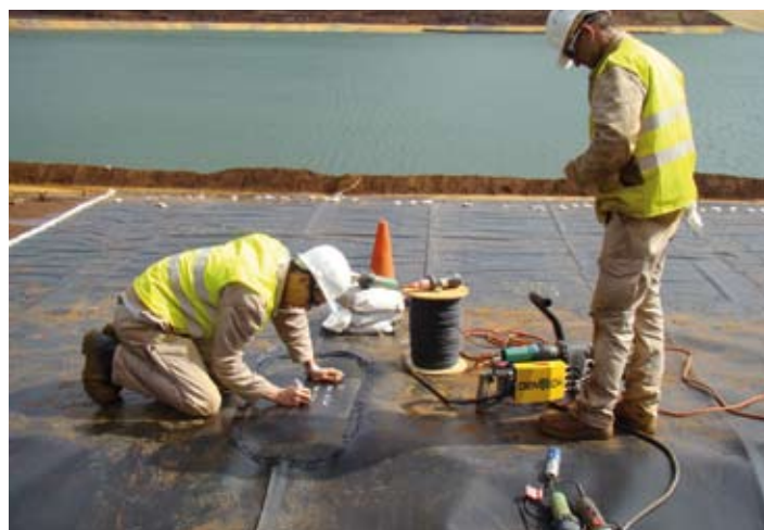
L'étanchéité est régulièrement contrôlée. Ici c'est la soudure qui est soumise à une surpression de 3 bars pendant 5 minutes. Il ne faut pas de baisse de pression pour valider le travail.
